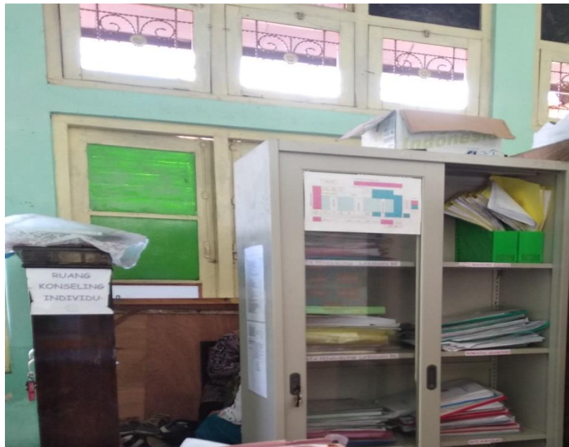
Gambar 4.5 Ruang Konseling yang tidak memadai
