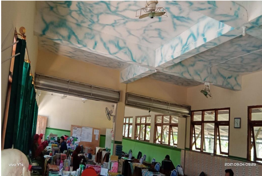
Gambar. 4.3 Ruang kantor yang sudah renovasi
