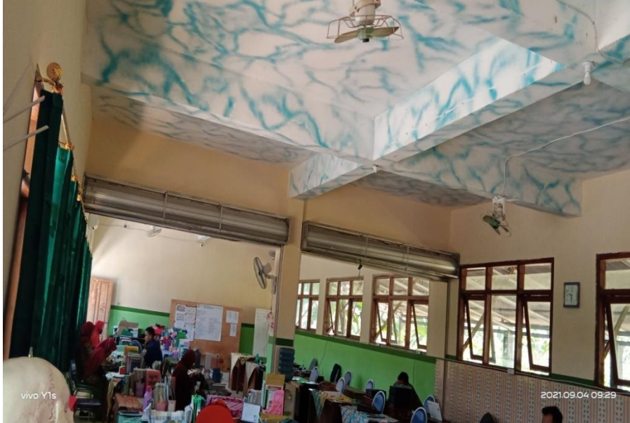
Gambar 4.1 Ruang kantor dan penempatan perabotan kantor
