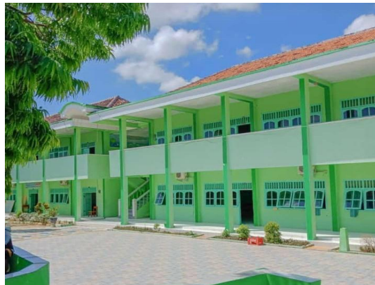
Gambar 1.3 Gedung MA Nurul Islam Karangcempaka
