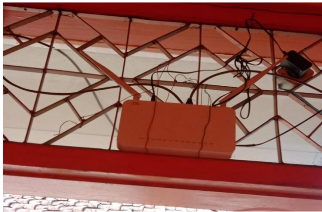
Gambar 4.5 : Gambar ini merupakan alat yang mengakses jaringan internet dalam lingkungan sekolah tersebut yang disebut Access Point
