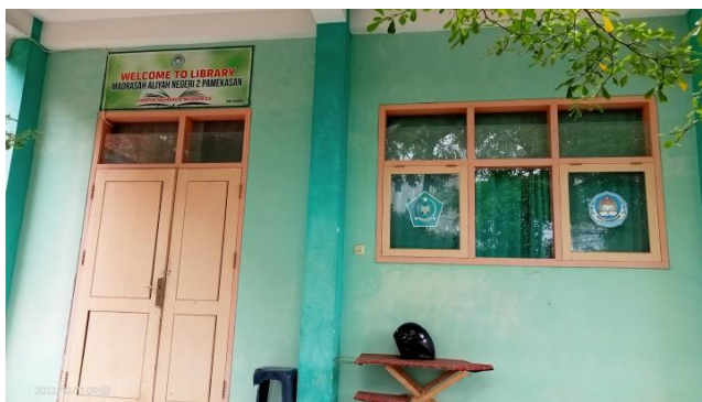
Gambar 4.8 Foto tampak depan bangunan perpustakaan lama
