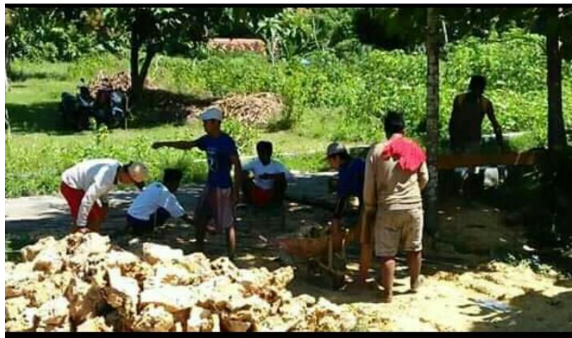
Gambar 4. 8 Proses pembangunan madrasah
