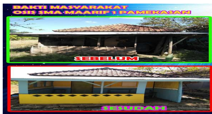
Dokumentasi bedah rumah sebelum dan sesudah
