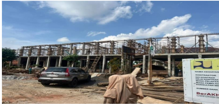
Gambar 4.7 Pembangunan Gedung Baru MAN 1 Pamekasan
