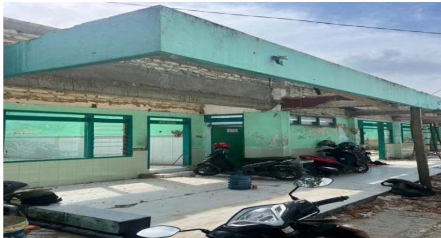
Gambar 4.8 Perbaikan Pada Ruang Guru di MAN 1 Pamekasan
