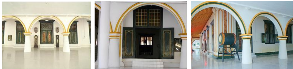
Gambar 12 Gambar Pintu dan Jendela Masjid Jamik Sumenep yang memiliki Unsur Budaya Madura
